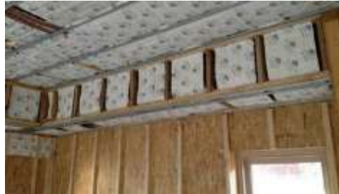
Slika 7: Makroenkapsulirani organski PCM 26
