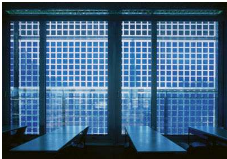
Slika 3: Primer BIPV – v ovoj stavbe integrirani fotonapetostni elementi 17
