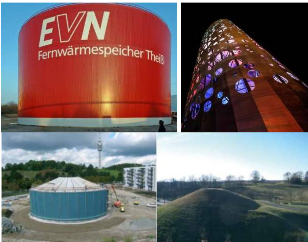
Slika 28: akumulacijski stolp daljinskega ogrevanja od Theiss pri Kremsu na Donavi v Spodnji Avstriji s toplotno zmogljivostjo 2 GWh (levo) in stolp za shranjevanje toplote v Bozen-Bolzanu, Južna Tirolska, Italija (desno) ter velik shranjevalnik toplote “Am Ackermann-bogen” v Münchnu, Nemčija (gradnja spodaj levo in končno stanje spodaj desno).
