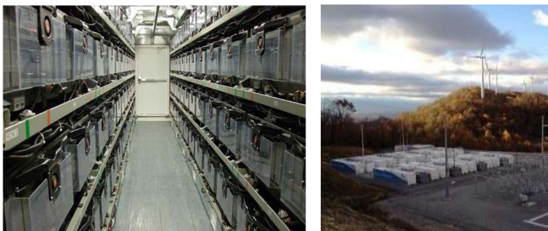
Slika 12: Notranjost (levo) in zunanost (desno) baterijske postaje Laurel Mountain, izvedene z Li-ion baterijami
