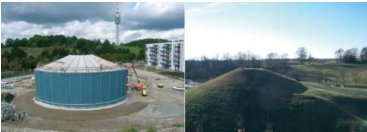
Slika 28 prikazuje dva shranjevalnika v bližini: akumulacijski stolp daljinskega ogrevanja od Theiss pri Kremsu na Donau v Spodnji Avstriji s toplotno zmogljivostjo 2 GWh in stolp za shranjevanje toplote v Bozen-Bolzanu, Južna Tirolska, Italija [33] ter veliko skladišče tople vode "Am Ackermann-bogen" v Münchnu, Nemčija.
